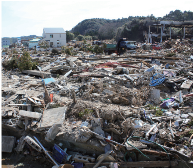
平地区の被害【写真提供：いわき市】
