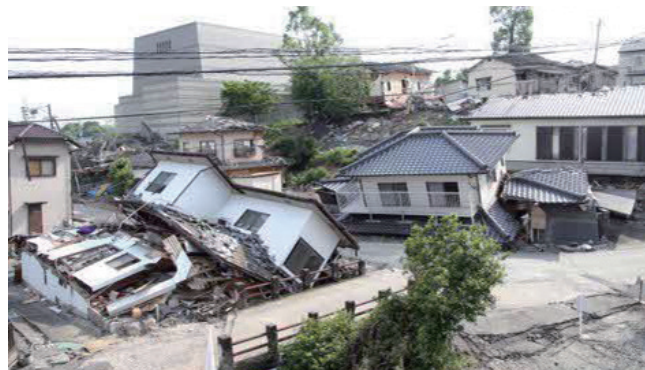
倒壊した家屋(寺迫地区)
