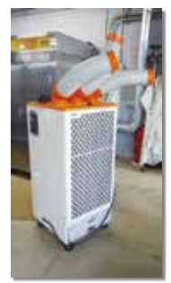
■給食調理場に設置されたスポットクーラー
