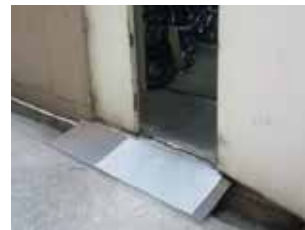
駐輪場裏口の鉄製傾斜板に滑り止め板を設置(改善事例)
